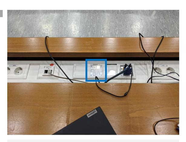
**Schalten Sie den Projektor** ein. Das Bedienfeld mit den entsprechenden Schaltern (Beschriftet mit z.B. *Beamer 1*) finden Sie innerhalb der Anschlussleiste im Rednerpult.
